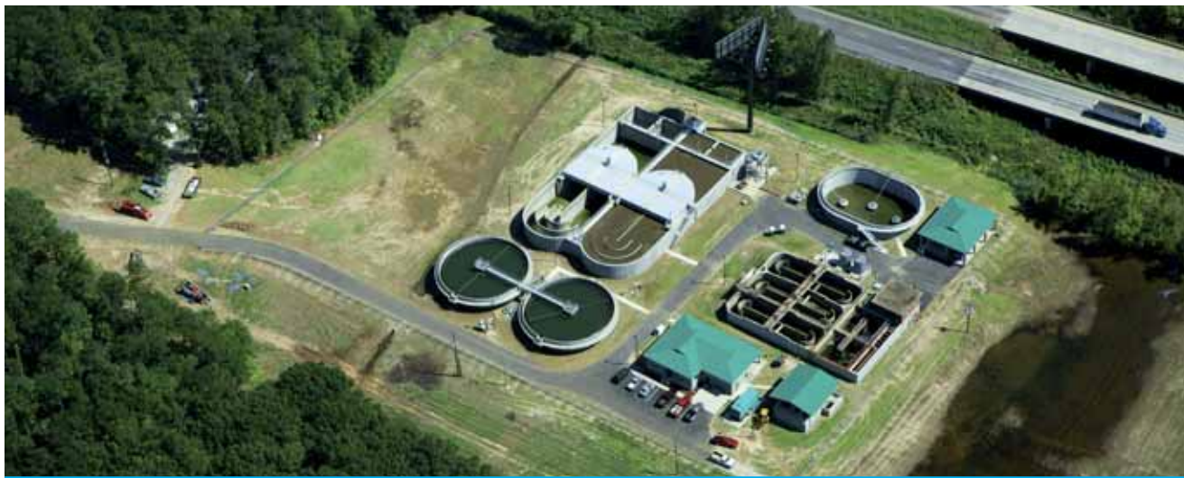
Пречиствателна станция за отпадъчни води
