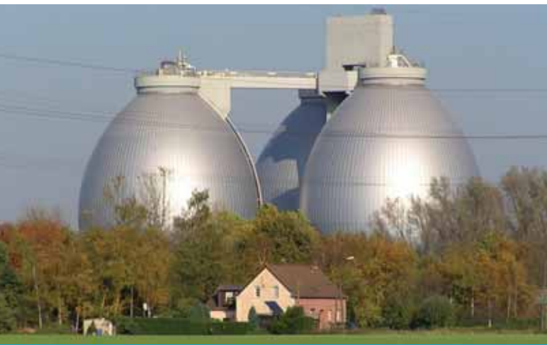
Цистерни за анаеробно разграждане, пречиствателна станция за отпадъчни води „Емшермондунг“ (Германия)
